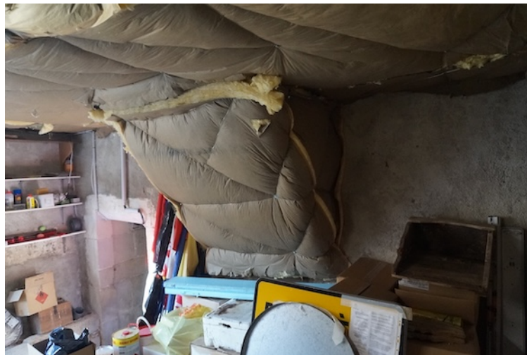
Plancher et escalier mairie isolés avec une laine de verre ép. 200mm
