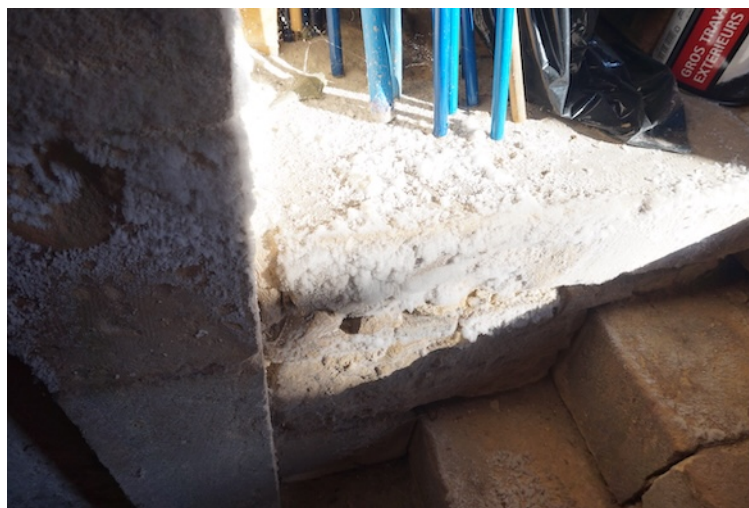
Présence de salpêtre: révélateur de présence d'humidité
